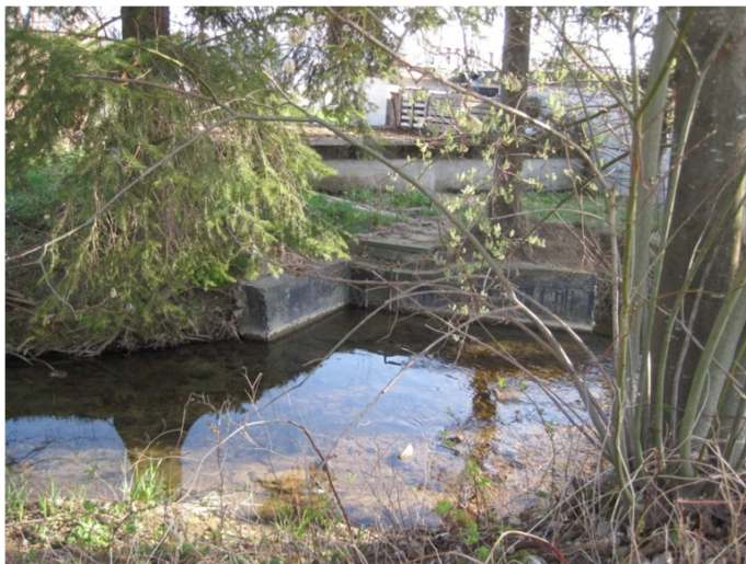
Figure 25 Vue de la prise d'eau existante (Source : RWB – 2.4.2014)
