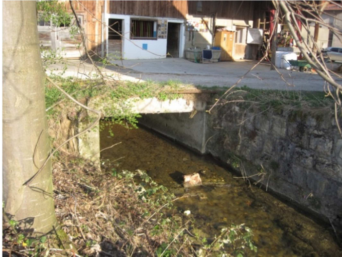
Figure 26 Emplacement prévu pour la station de mesure (Source : RWB-2.4.2014))
