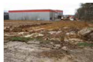
Fig. 2.3 Alle – La Fenatte. Le terrassement vu depuis l'est. Photo P.-A. Borgeaud, OCC-SAP
