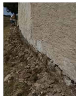
Fig. 2.177 (à gauche) Porrentruy – Le Château. La petite tranchée le long des murs du château.
