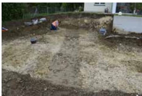
Fig. 2.88 (à gauche) Develier – La Communance, parcelle 3608. La parcelle en cours de décapage vue depuis le sud-est. Photo P.-A. Borgeaud, OCC-SAP
