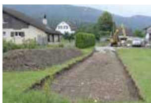
Fig. 2.152 Vicques – La Frimesse. Le chemin d'accès vu depuis le sud-ouest. Photo P.-A. Borgeaud, OCC-SAP
