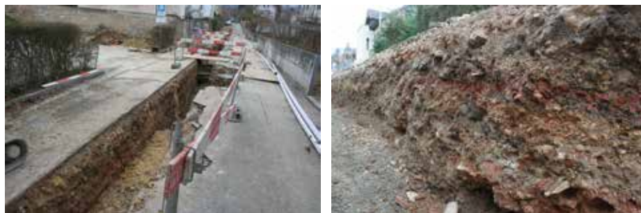
Fig. 2.185 (à gauche) Porrentruy – Pré Tavanne. La tranchée vue depuis le nord-est. Photo P.-A. Borgeaud, OCC-SAP
