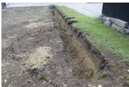
Fig. 2.92 (à gauche) Develier – La Communance, parcelle 3608. Extension sud du fossé st. 1 au premier plan, à l'emplacement de la piscine. Photo P.-A. Borgeaud, OCC-SAP
