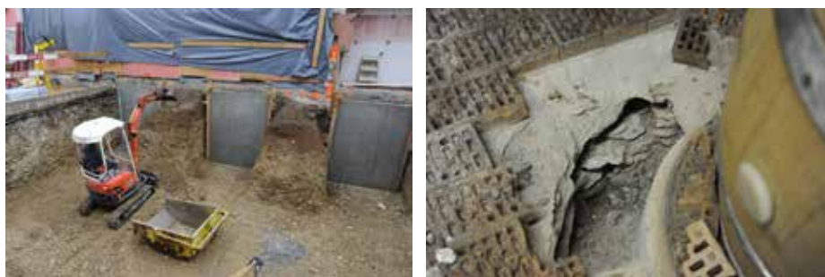
Fig. 2.64 (à gauche) Courroux – Le Raisin. Creusage profond de la brasserie avec les approfondissements par étapes des fondations. Photo P.-A. Borgeaud, OCC-SAP
