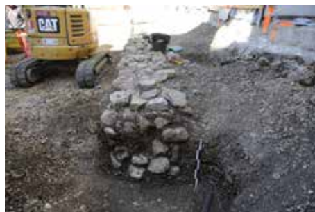
Fig. 2.33 (à gauche) Courroux – Le Raisin. Le mur st. 1 en cours de dégagement, vu depuis le sud. Photo P.-A. Borgeaud, OCC-SAP
