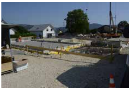
Fig. 2.129 (à gauche) Rossemaison – Copas de Sel. La stratigraphie dans la partie méridionale de la zone à bâtir. Photo P.-A. Borgeaud, OCC-SAP
