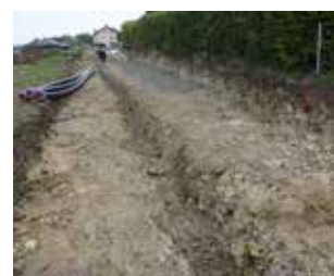
Fig. 2.5 Alle - Sur les Vies de Bâle. Tranchée de viabilisation vue depuis l'est, à l'endroit du futur chemin. Photo P.-A. Borgeaud, OCC-SAP
