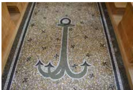
Fig. 2.141 (à gauche) Vermes – Eglise. Le terrazzo du vestibule d'entrée avec sa date de 1899, la vue est prise depuis l'escalier du balcon. Photo P.-A. Borgeaud, OCC-SAP
