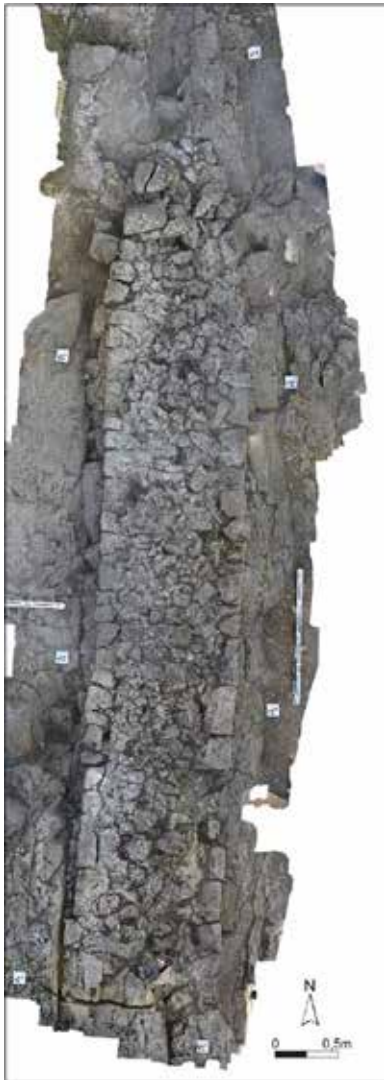
Fig. 8 : Le mur oriental. Vue totale depuis le dessus. Photogrammétrie OCC-SAP, Y. Maître.
