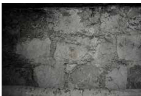
Fig. 2.135 (à gauche) Saint-Ursanne – Sarcophage. À l'arrière du sarcophage, la maçonnerie est très friable. Photo K. Marchand, OCC-SAP
