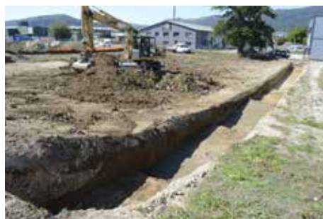
Fig. 2.70 (à gauche) Delémont – Les Prés de la Commu- nance. Le début du terrassement et la tranchée vus depuis le sud-est. Photo P.-A. Borgeaud, OCC-SAP
