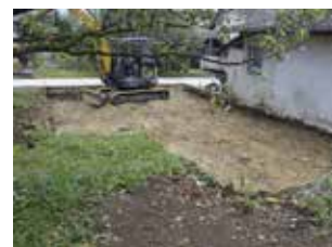
Fig. 2.86 Delémont – La Communance, parcelle 1387. Le terrassement vu depuis l'ouest. Photo P.-A. Borgeaud, OCC-SAP
