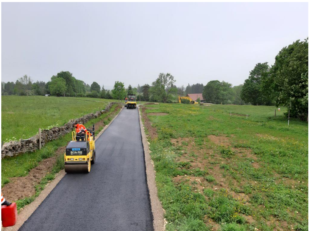
Photo 2 : SCB 2, Travaux de la 2 e étape
